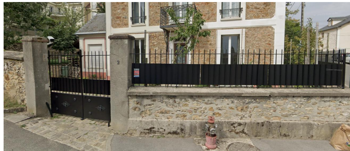
Mur bahut en pierre surmonté d'une clôture en fer forgé semi opaque
