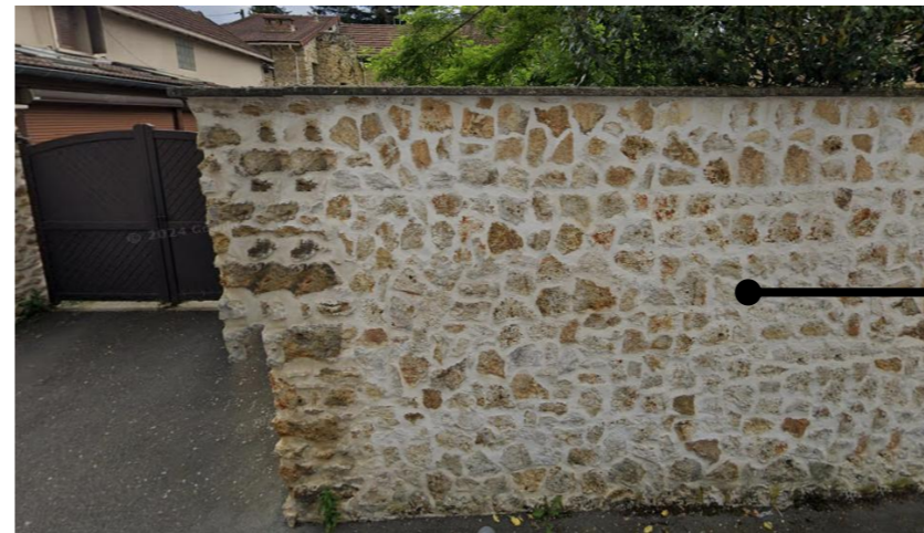
Mur plein en pierre maçonnée
