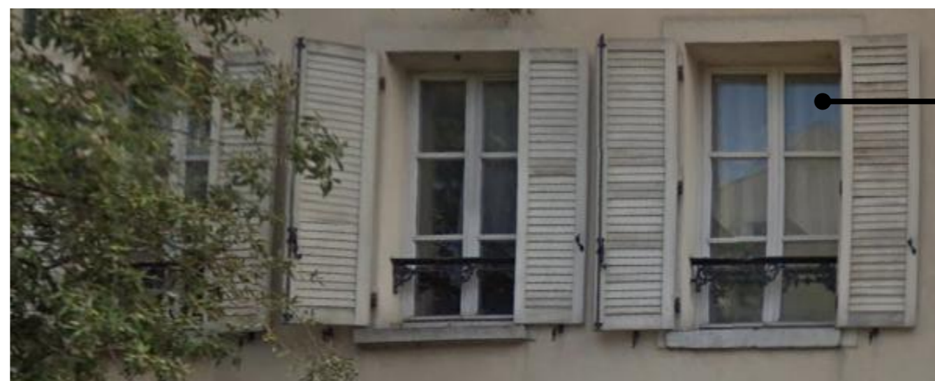
Fenêtres à 6 carreaux
