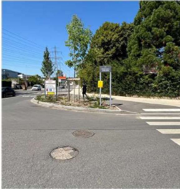
Angle rue Sablière et rue Lavoisier
