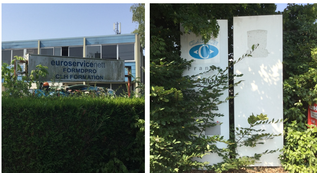
Exemples d'enseignes scellées au sol en mauvais état d'entretien
