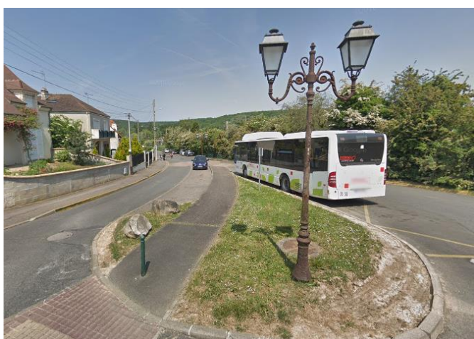
Gare routière à restructurer au niveau de l'avenue de Gommonvilliers
