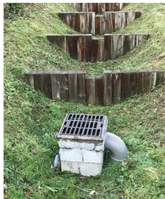
Noue à Vauhalla
