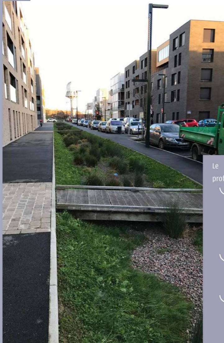
Exemple de noue à Palaiseau La noue crée un espace vert qui limite le ruissellement des bâtiments et de la voirie.
