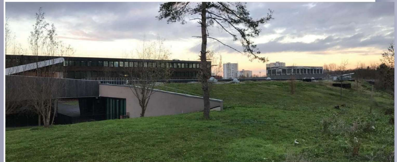
Exemple de toiture végétalisée à Massy La toiture végétalisée est un élément architectural qui intègre le bâtiment à son environnement et permet une meilleure gestion des eaux pluviales.
